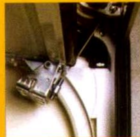
Dispositivo de seguridad por rotura de cables
